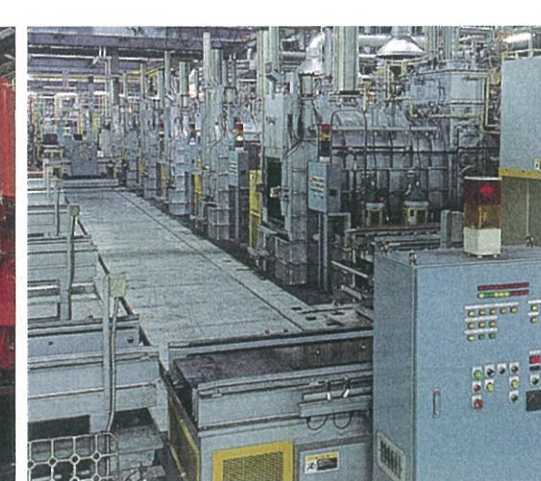
環境にやさしいノンフレーム式ガス炉(熱処理設備)
